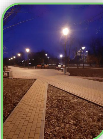
Будівництво алеї на території ж/м Піщаний
